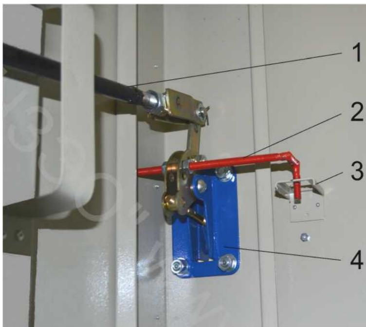
Рисунок 3 Работа блокировки двери в камерах КСО трехсотой серии с габаритом 1, 2, 3
